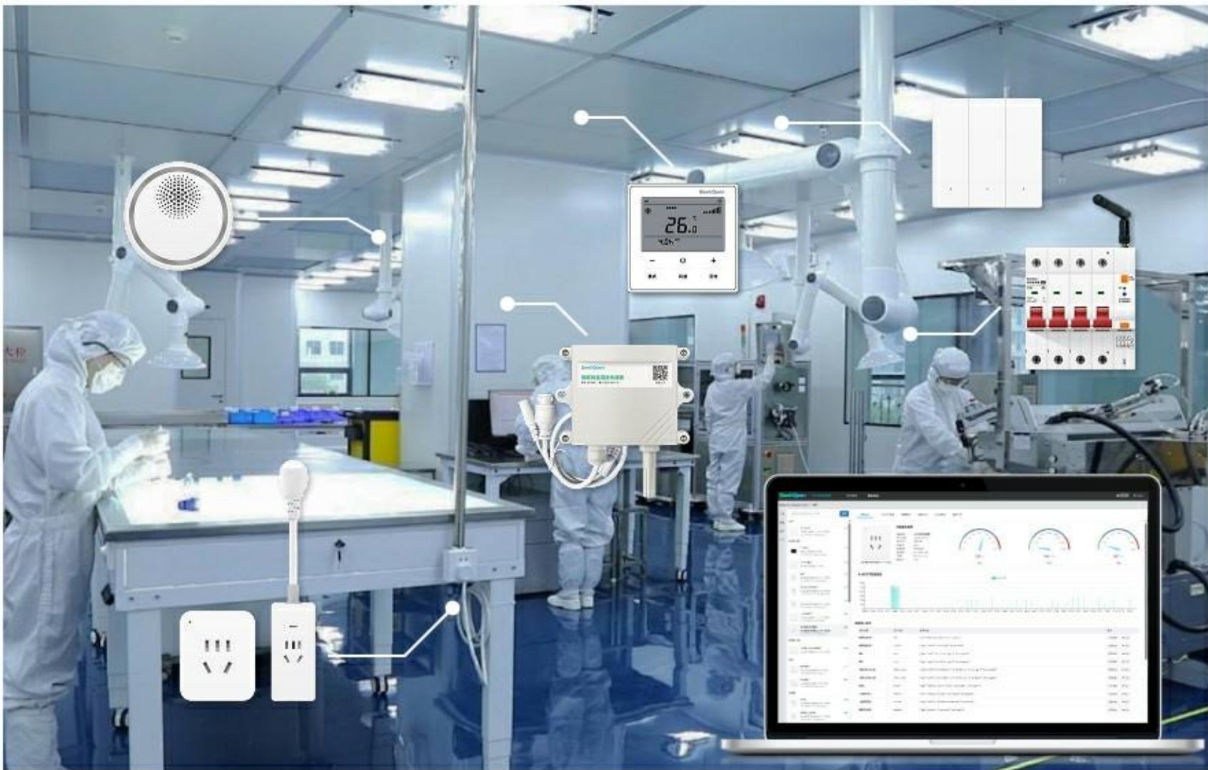
实验室用电监控
