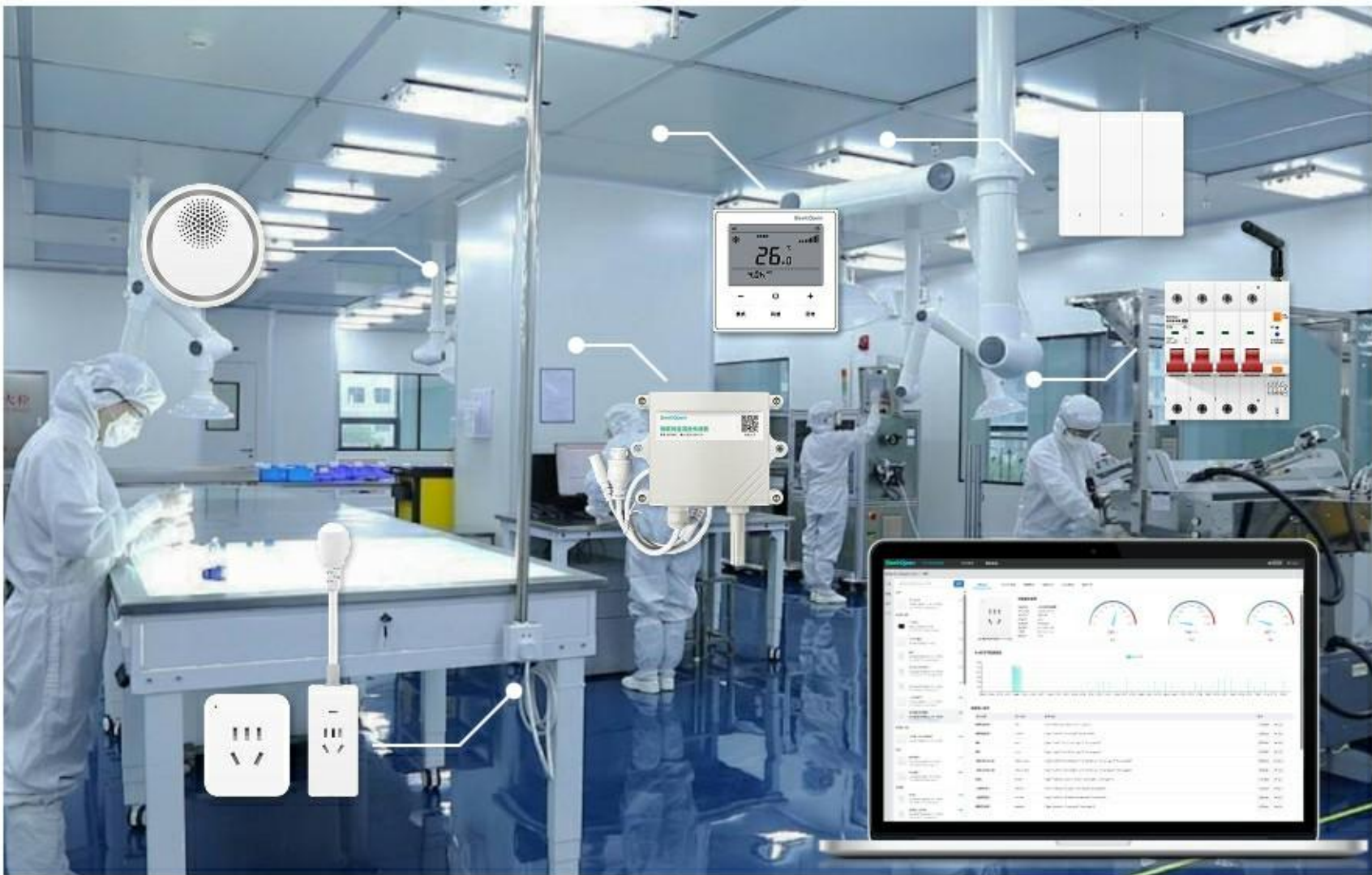
实验室用电监控
