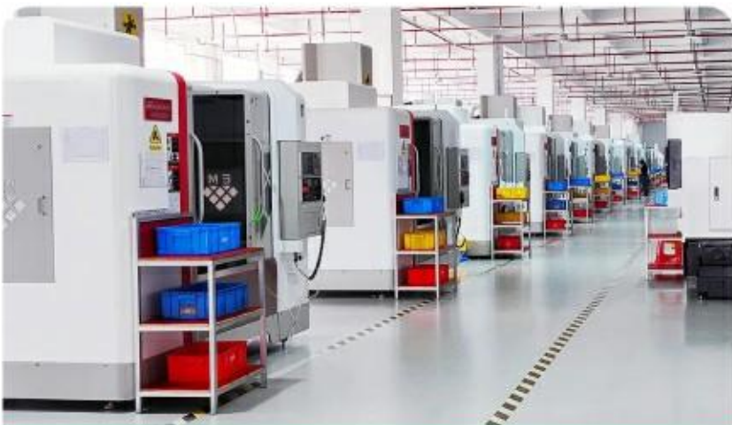
工厂车间安防电源监控
