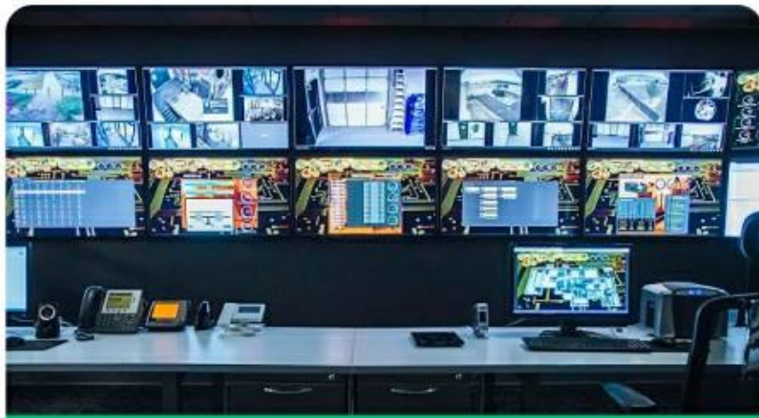
安放应急设备管
