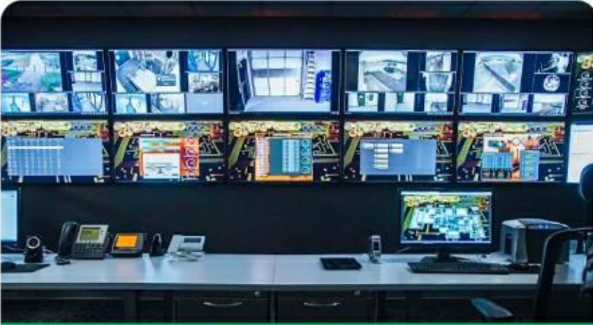
安放应急设备管
