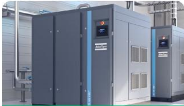
设备间/弱电箱管理
