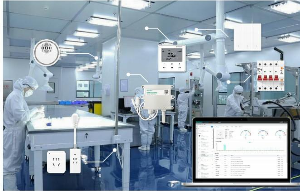
实验室用电监控
