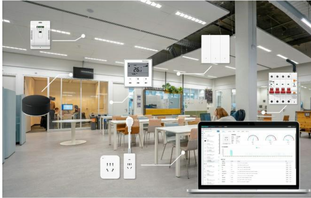
办公园区用电监控
