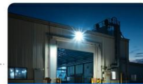
工地/厂房用电管理
