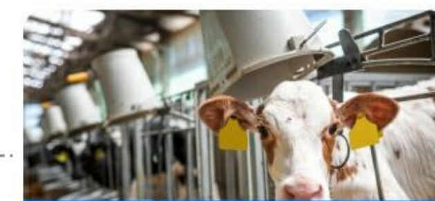
养殖场通风换气设备
