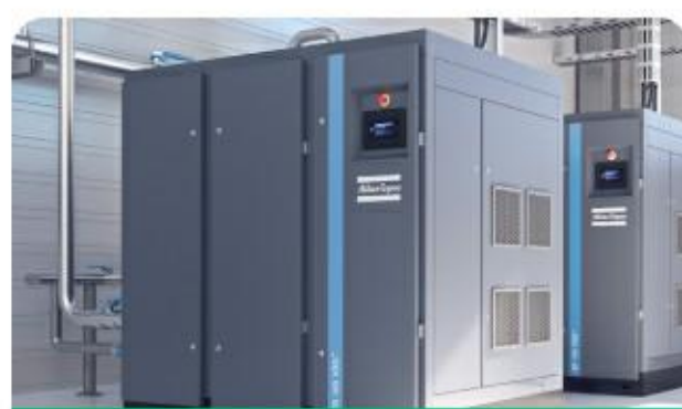
设备间/弱电箱管理
