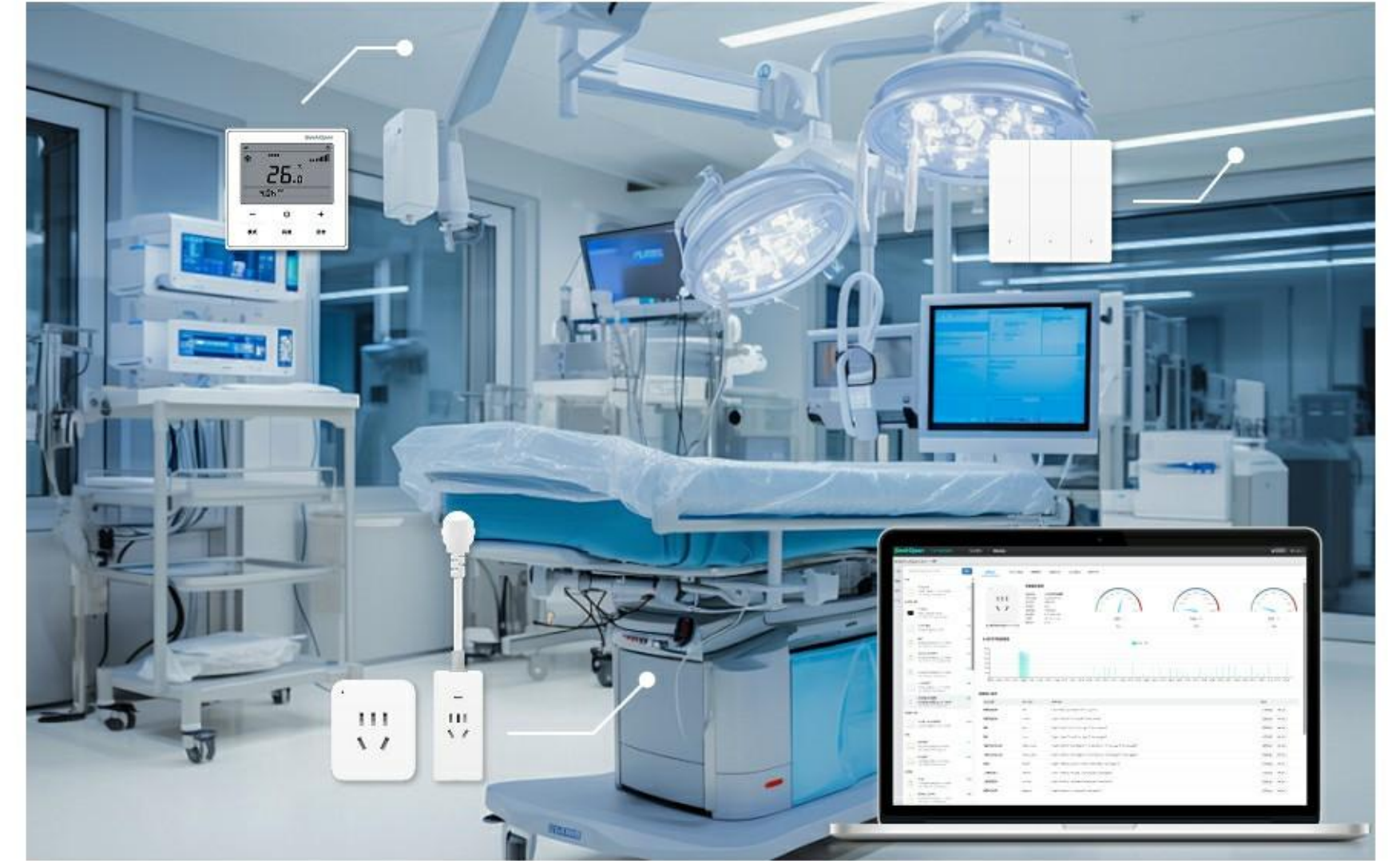
医疗诊室用电监控
