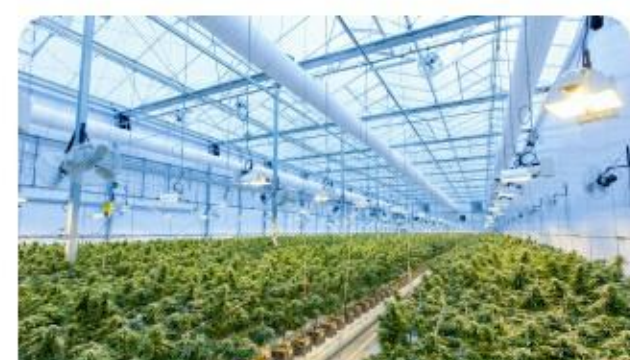
温室大棚系统电源监控
