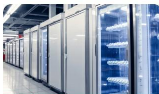
药品生鲜冷柜电源监控
