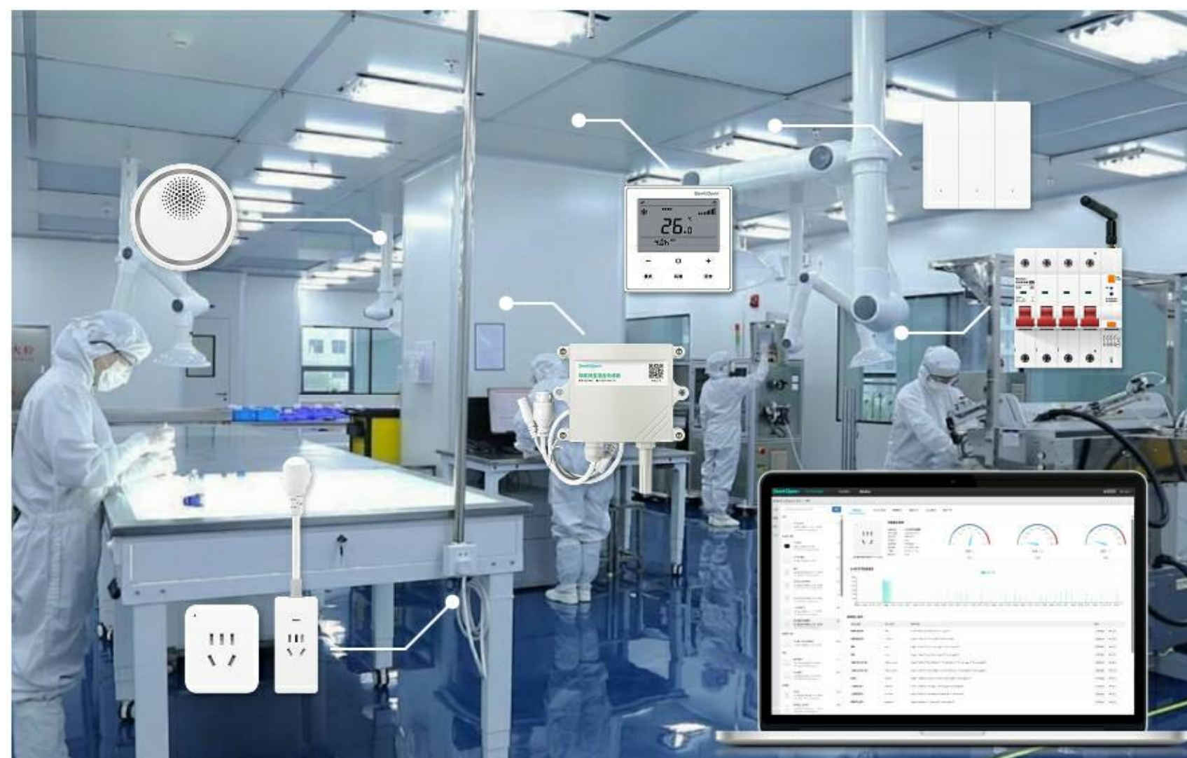
实验室用电监控
