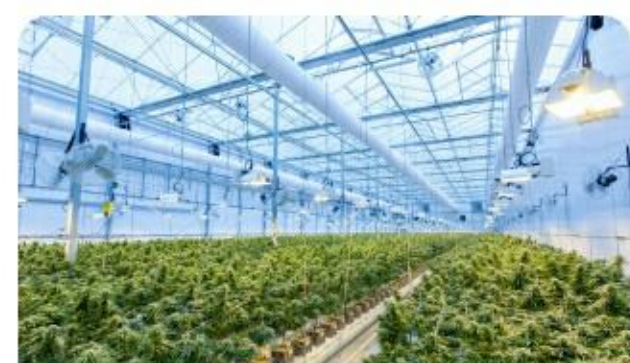
温室大棚系统电源监控
