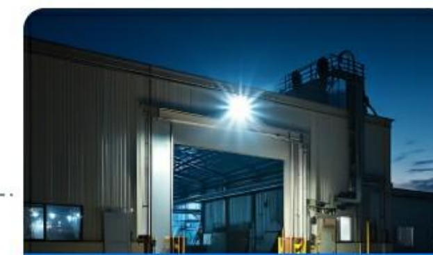
工地/厂房用电管理
