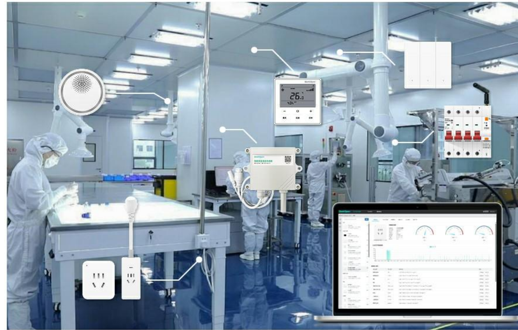
实验室用电监控
