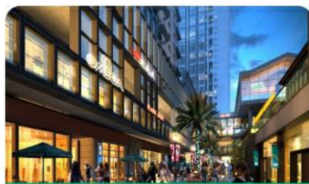
店铺/橱窗照明
