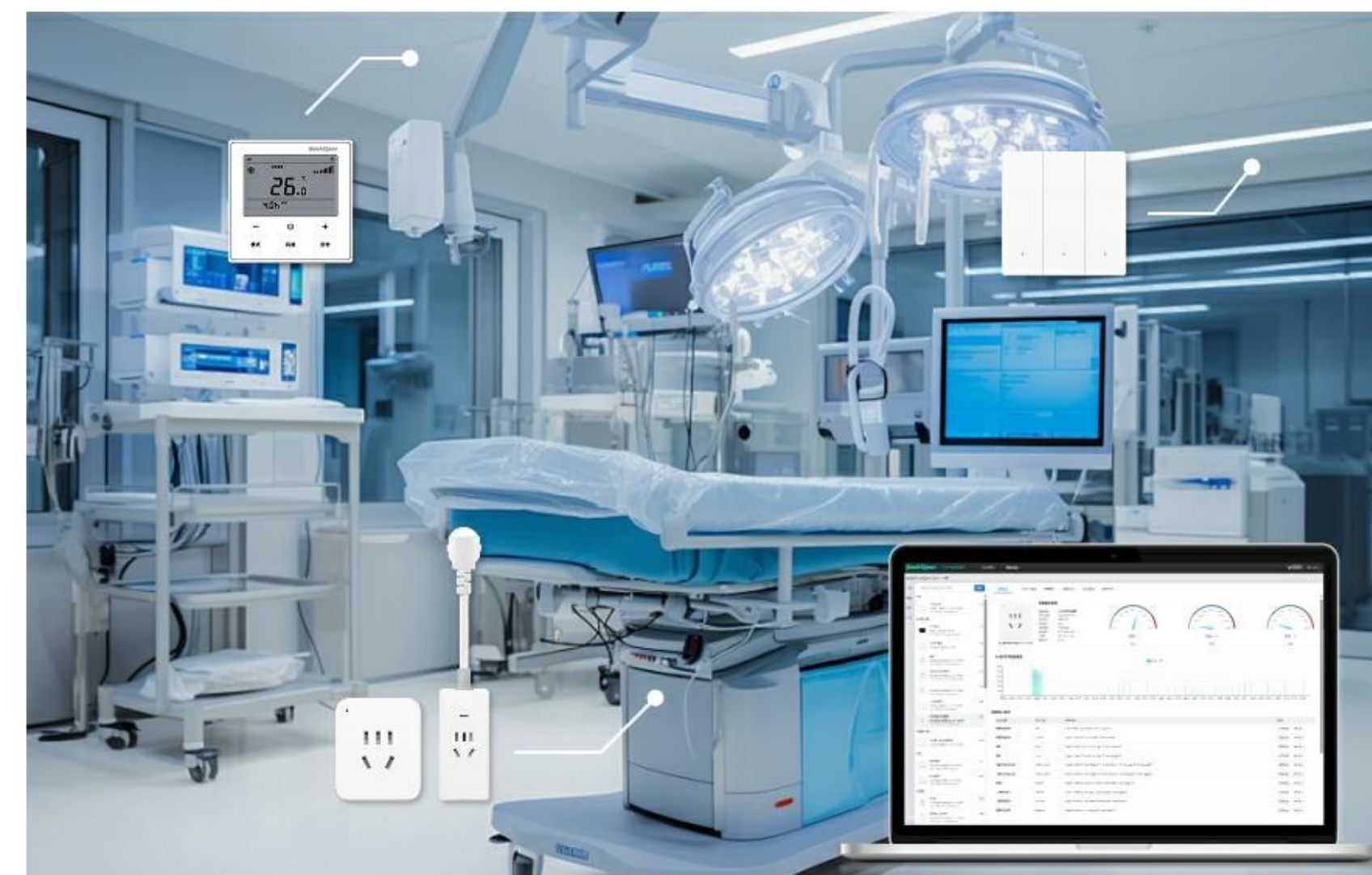
医疗诊室用电监控
